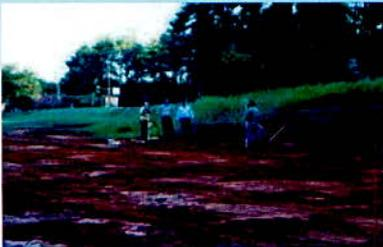
**Nivelación topográfica del terreno:** Se realiza para que el terreno mantenga una condición uniforme y evite que hayan encharcamientos o depresiones que se puedan inundar.
